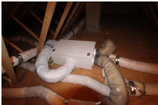
Ventilasjonsaggregat.
