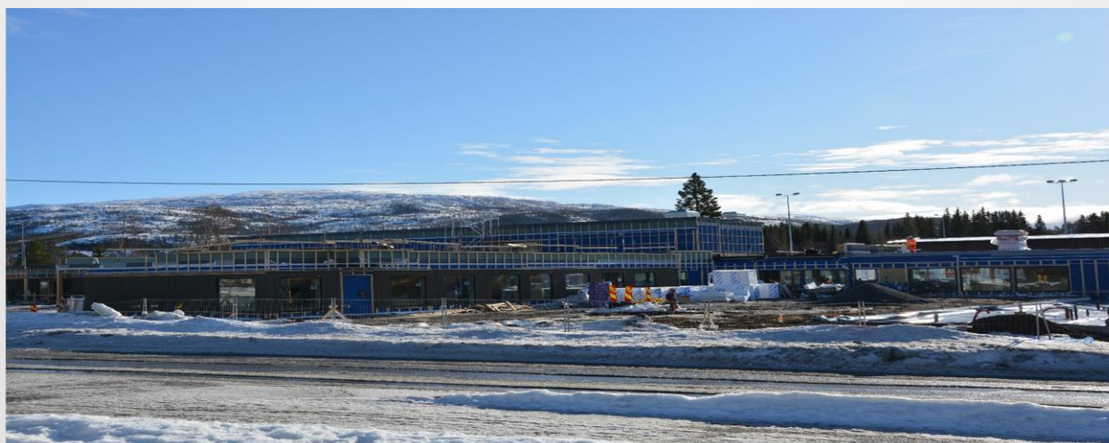
(Bygging av Grane helsetun, våren 2020)
