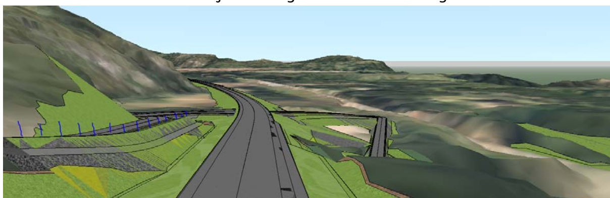
Figur 5.10 Langtjønnevegen er skilt fra E6 med voll og gjerde, slik at reinflokker ved flytting kan ledes til et samlegjerde før passering av veg og jernbane (se kapittel om reindriften).
