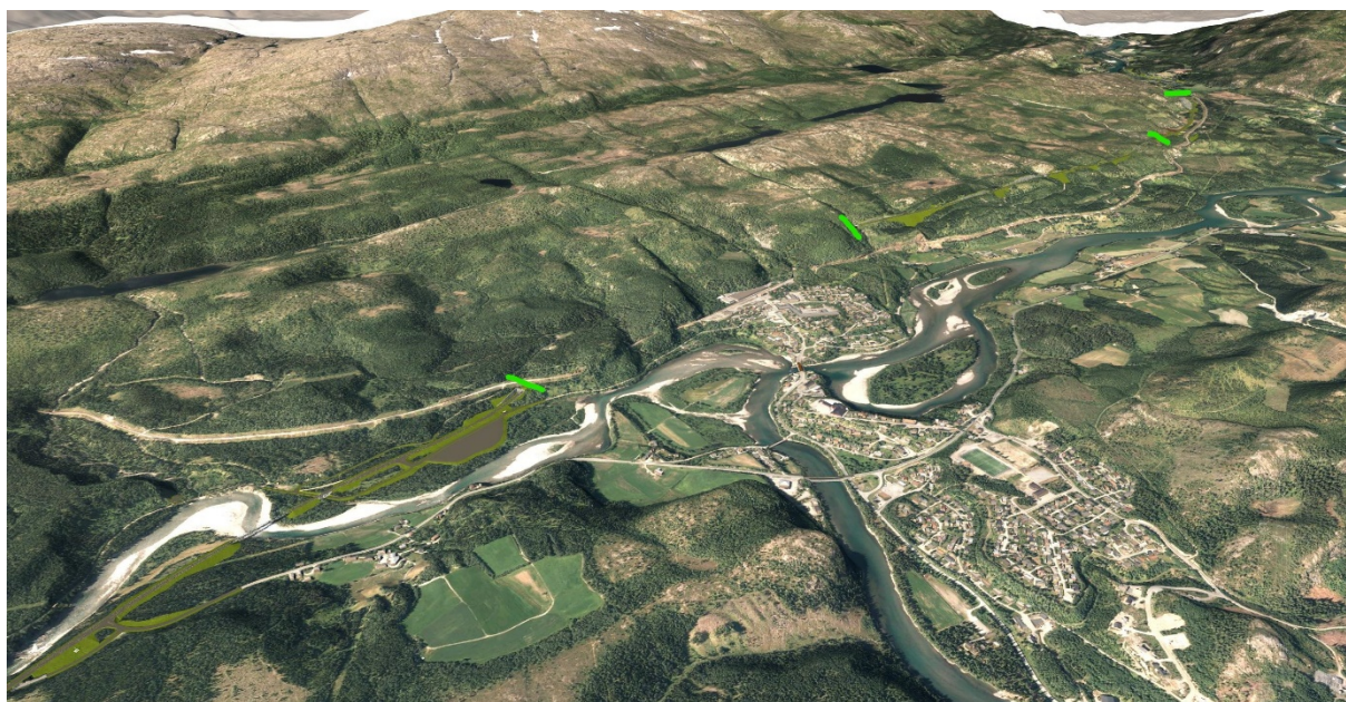
Figur 5.7 E6-traseen sett fra sør mot nord
