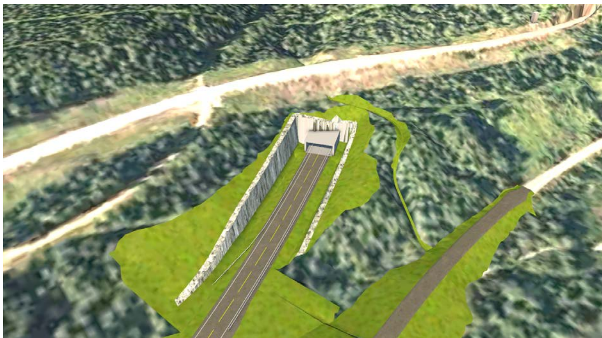
Figur 5.21 E6 legges i tunnel under jernbanen ved Vollen.
