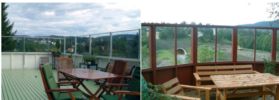
Figur 2 - Eksempel på lokale støytiltak på uteplass for støyutsatt bebyggelse. Figur er hentet fra SVV Håndbok 135 Fasadeisolering mot støy (Statens vegvesen, 2014).
