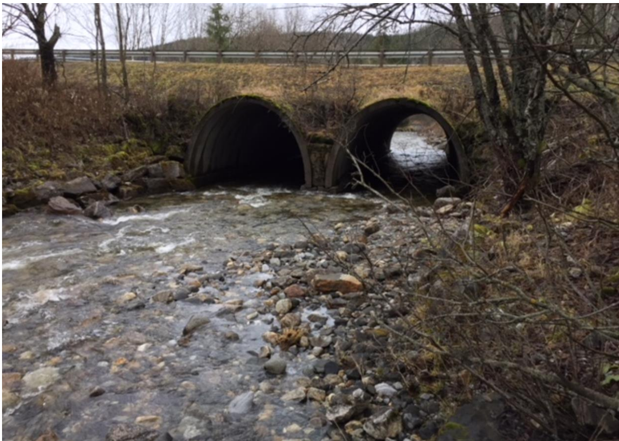
Figur 72 Bilde av Almdalselva oppstrøms kulvert under E-6.
