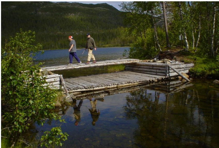
Fløterdam Stavatnet. Foto: Are Halse
